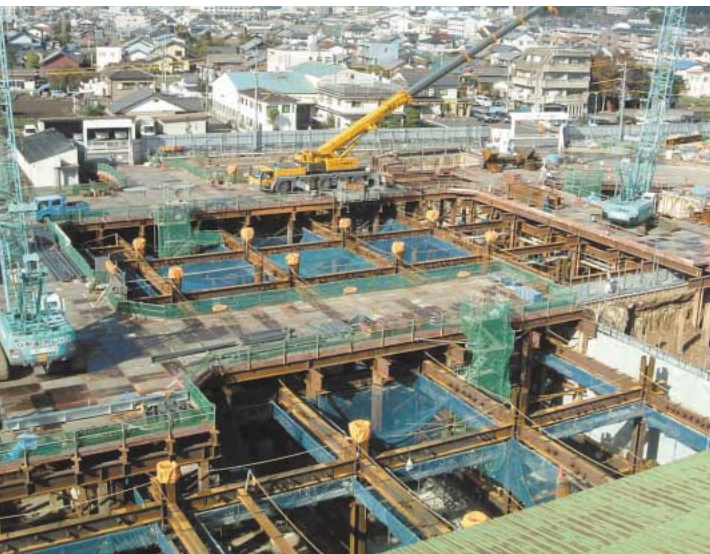
建設の状況(平成16年12月)
