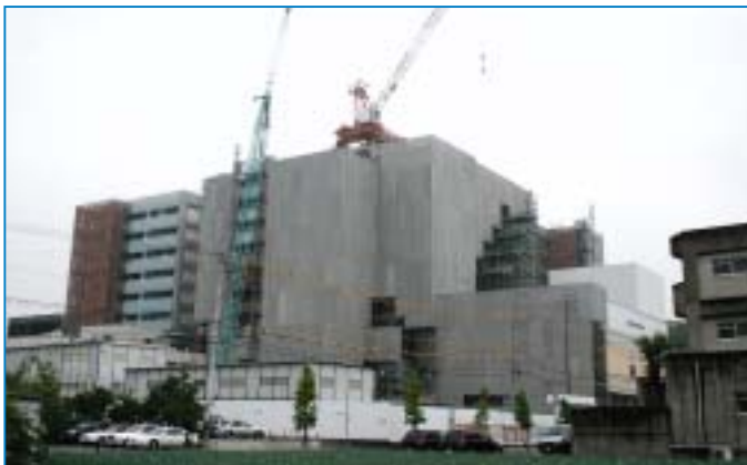
建設中の岐阜県総合医療センター 平成18年6月26日撮影
